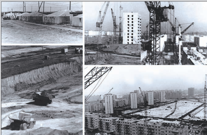
Строительство автогиганта КАМАЗ
