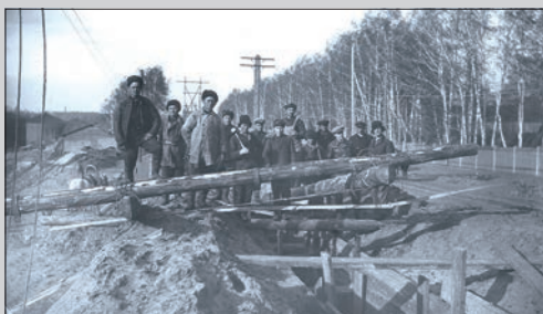
Прокладка кабельной линии. Казань, 1941 год
