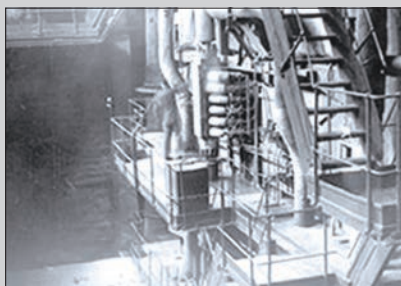
Распределительный щит котла Л.К. Рамзина. Казанская ТЭЦ-2, 1943 год
