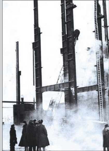
Монтаж колонн Урусинской ГРЭС. 1943 год
