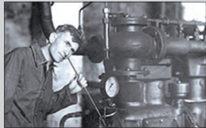
Казанская ТЭЦ-1. Начальник котельного цеха И.К. Гижиров. 1945 год
