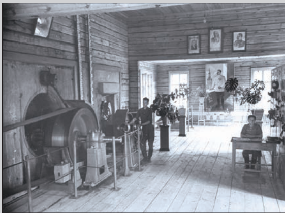
Внутренний вид межколхозной ГЭС
