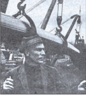
Строительство газопровода Оренбург – Заинск
