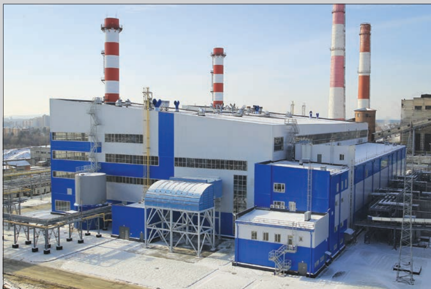
ПГУ-220 МВт. Казанская ТЭЦ-2
