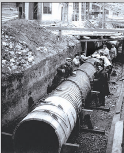
Строительство Казанской ТЭЦ-1. Начало 30-х годов
