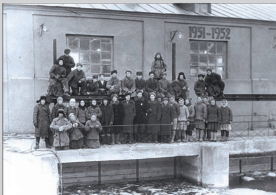
Строители Ново-Мелькенской ГЭС на реке Ик. 1952 год
