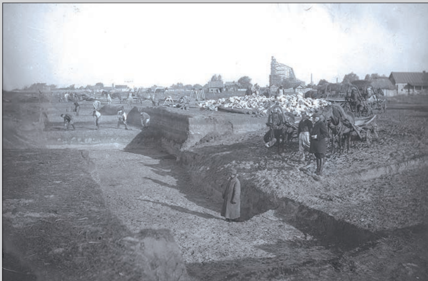
ТЭЦ-1. Производство земляных работ на месте станции
