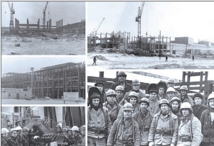
Строительство автогиганта КАМАЗ
