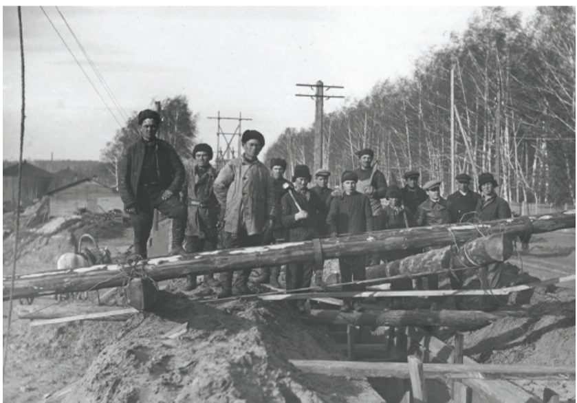
Перевод электроснабжения Казани с постоянного на переменный ток. 1920 год
